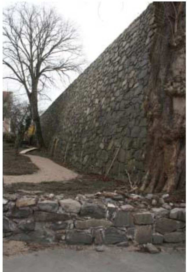
Sträckningsmuren vid Varvsgatan
